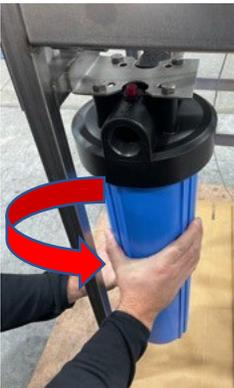
**STEP 8-** HAND TIGHTEN FILTER HOUSING BACK INTO HOUSING CAP.
